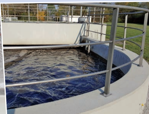
Nitrifikationsbecken nach Instandsetzung
