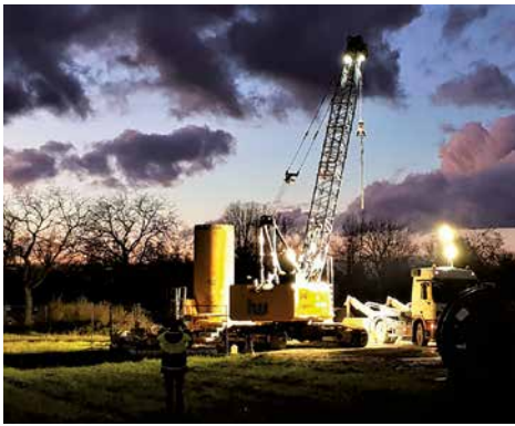
Brunnenbohrung Kappel (RHR Elzmündung)
